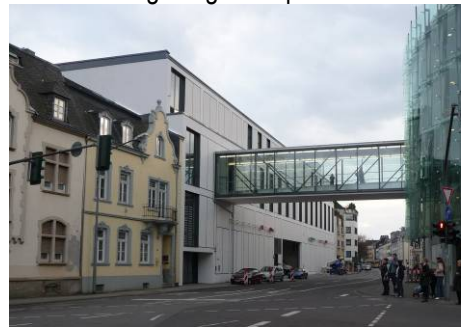
Verbindung zwischen City Parkhaus und Trier Galerie
